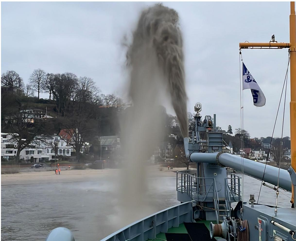
Abb. 3: Keine Schlickentsorgung, sondern Uferschutz im Januar 2023: Der Bagger „Ijssedelta“ spült im sogenannten Rainbow-Verfahren Sand auf den Strand bei Blankenese (Foto: HPA / Rudolf Islinger)
